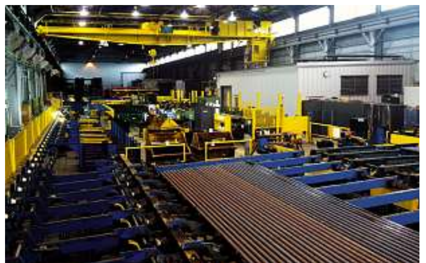
GGT unterstützte die Demontage-, Remontage- und Umrüstungsarbeiten.
